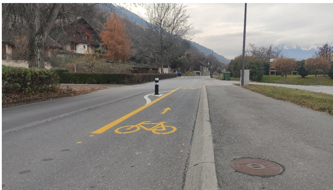
Aménagement cyclable modérant les vitesses des véhicules sur la route de Bramois
